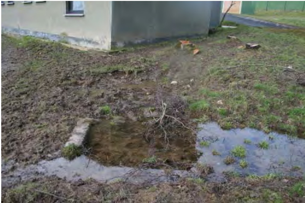
Bild 18: Durch Viehtritt verdichteter Ablauf mit der Folge des Rückstaus
