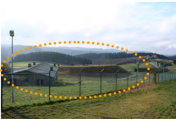
Bild 11: Beispiel einer Aufschüttung
