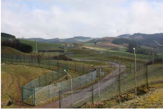
Bild 9: Blick über den nördlichen Teil des alten Militärgeländes
